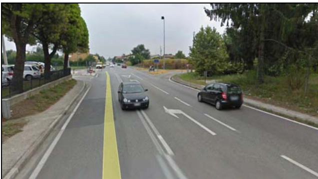
S.S. 516 "Piovese" in direzione Piove di Sacco e Padova
